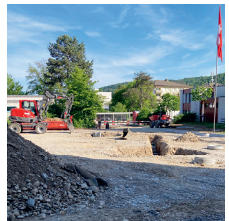
... für die Wasserableitungen ausgehoben.
