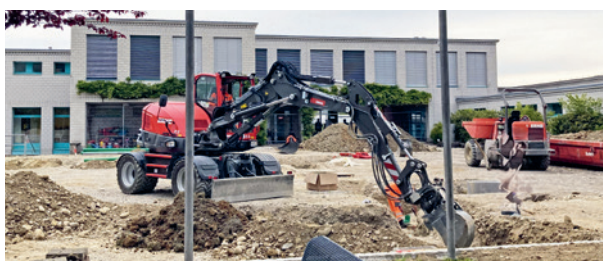
Mit Hilfe eines Baggers werden die Gräben ...
