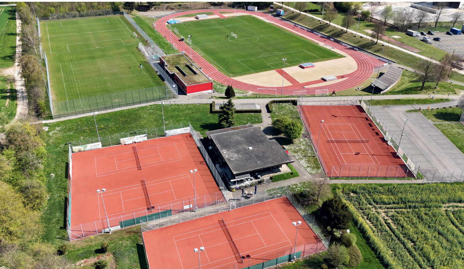
Das Clubhaus ist umgeben von vier Tennisspielfeldern. Rechts, das zum Grundstück gehörende Parkplatzareal.
