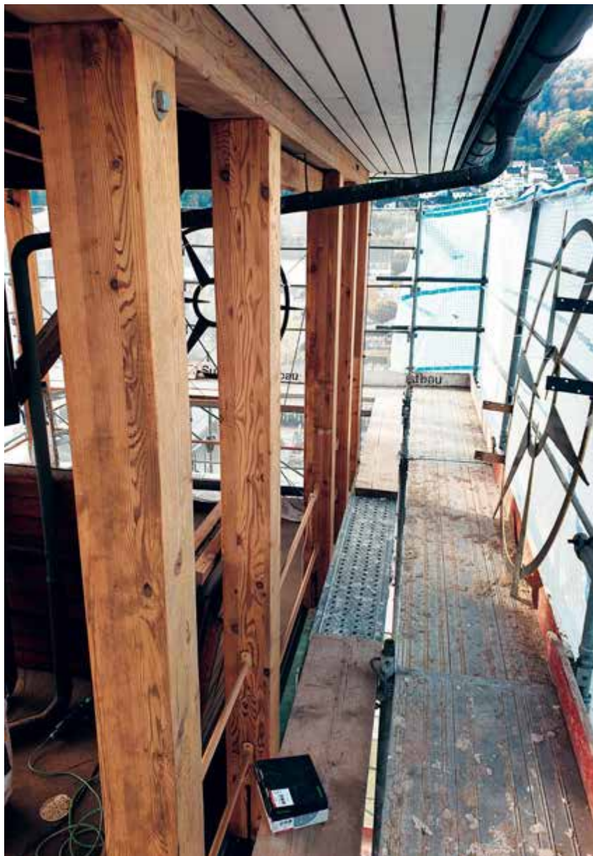
Jüngst durfte Stefan Süsslin den Kirchturm der römisch-katholischen Pfarrkirche von Stein neu streichen. Die Holzkonstruktion musste vollständig abgeschliffen werden
