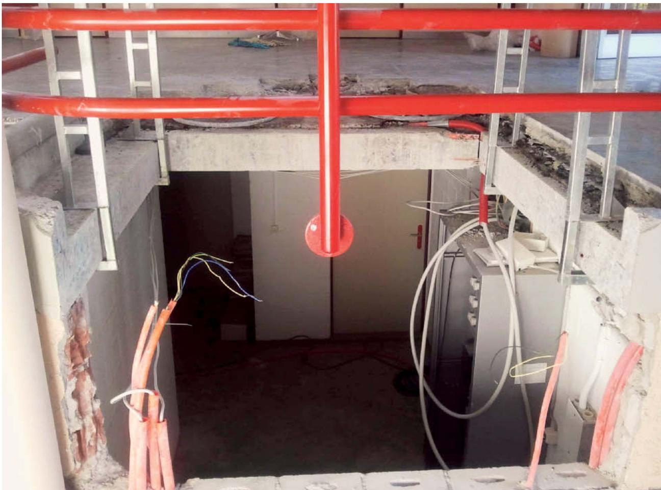
Für den Einbau des neuen Lifts musste die Decke im Zwischengeschoss durchbrochen werden
