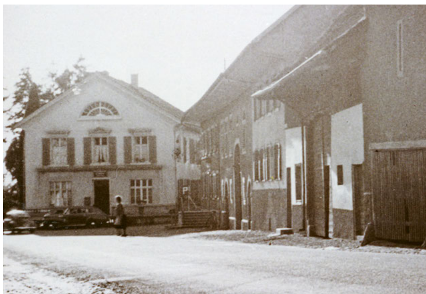
Eingang zur alten Post
