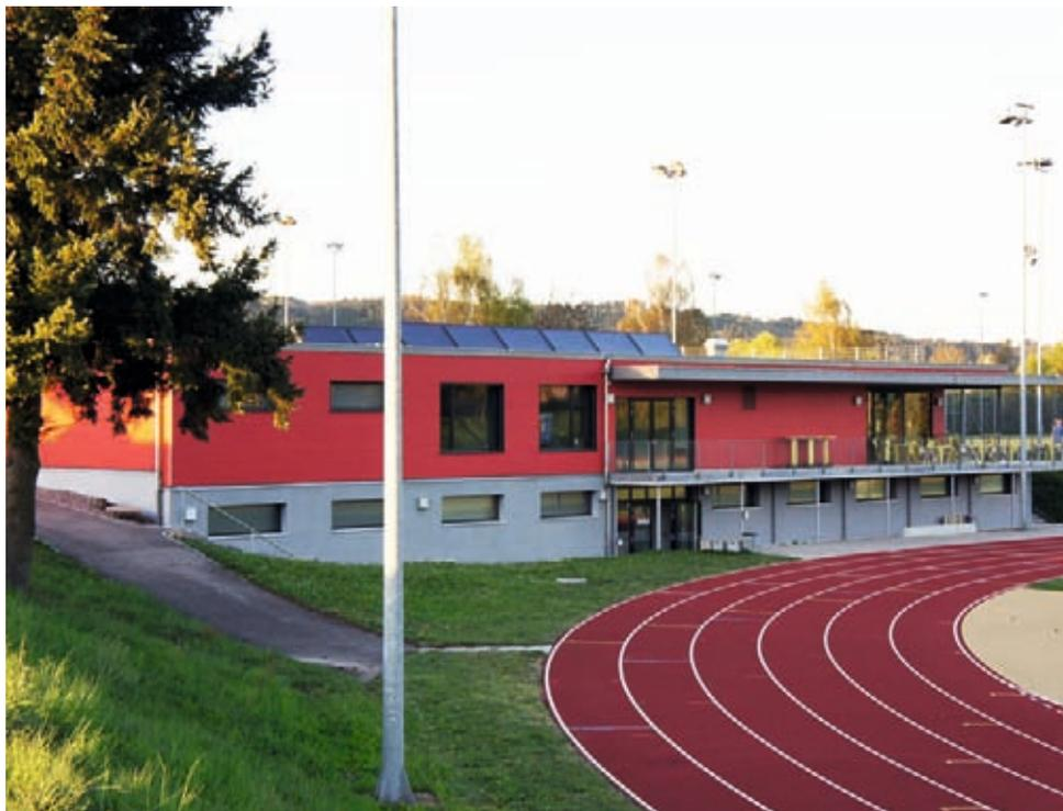
*Garderobengebäude Sportanlage Bustelbach: Minergie-P-Standard mit Grundwasserwärmepumpe und Solaranlage zur Warmwasseraufbereitung, sehr geringer Energieverbrauch*
