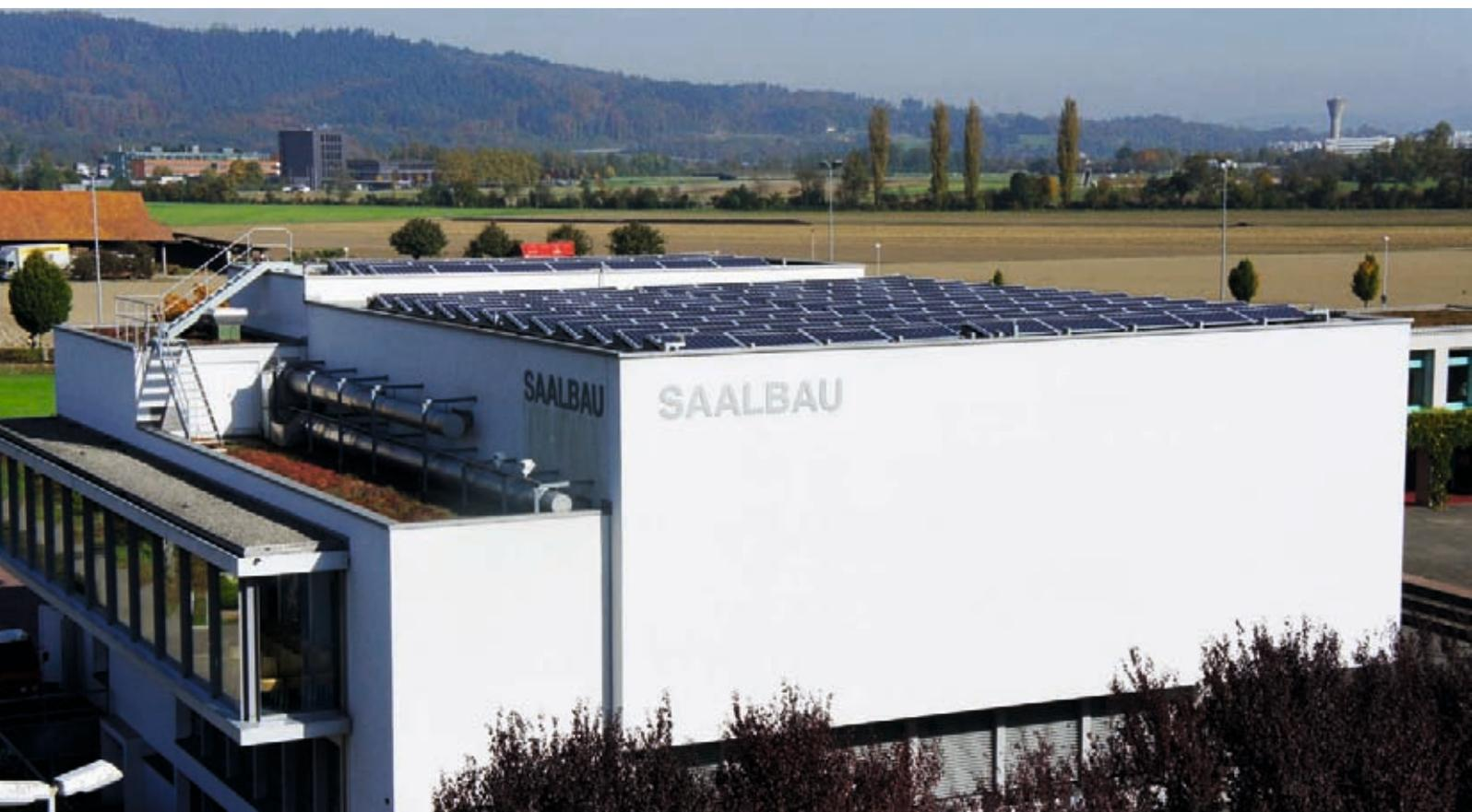
Photovoltaikanlage Saalbaudach: 29.6 kWp Stromproduktion 2013: 34'000 kWh
