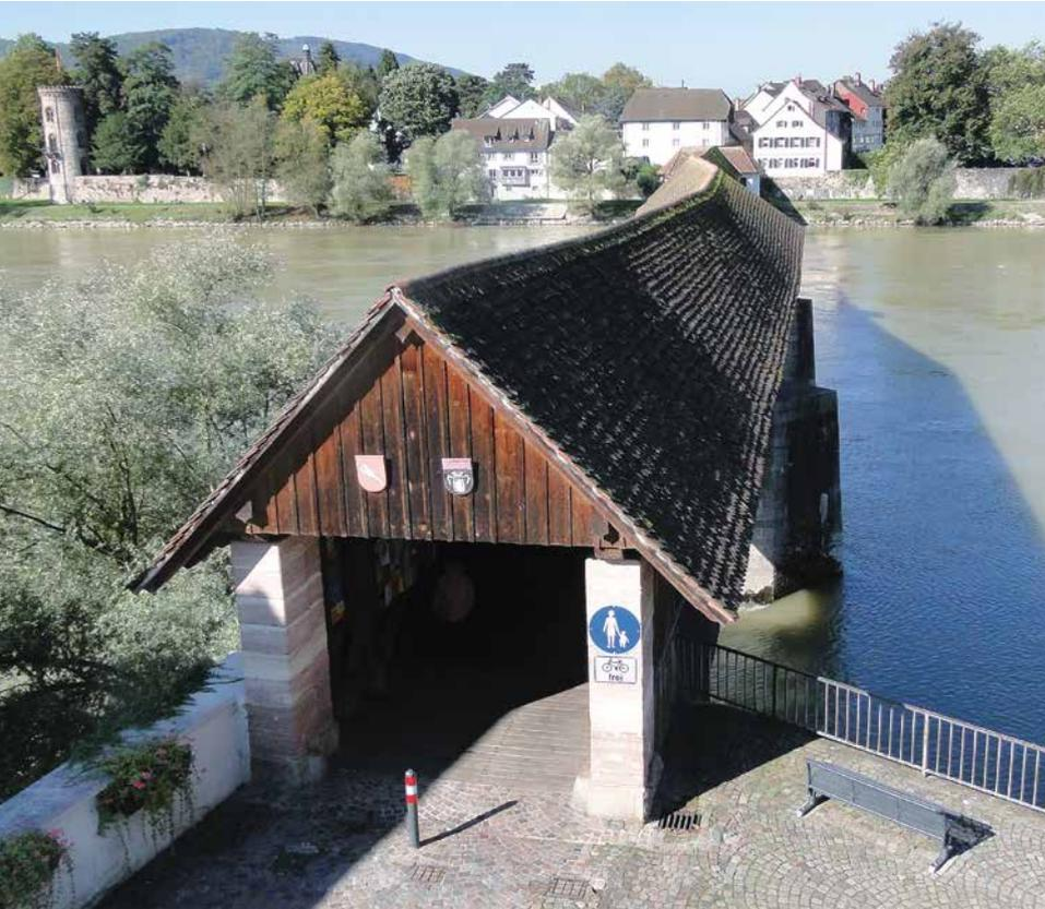
schliesslich das Gepräge, das sie heute noch hat: eine ausgefeilte Eichenholzkonstruktion, die auf sechs massiven Steinpfeilern ruht.
